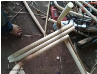
Gambar 21. Pemasangan sandaran tangan. Sumber foto: Dokumentasi Penelitian.
