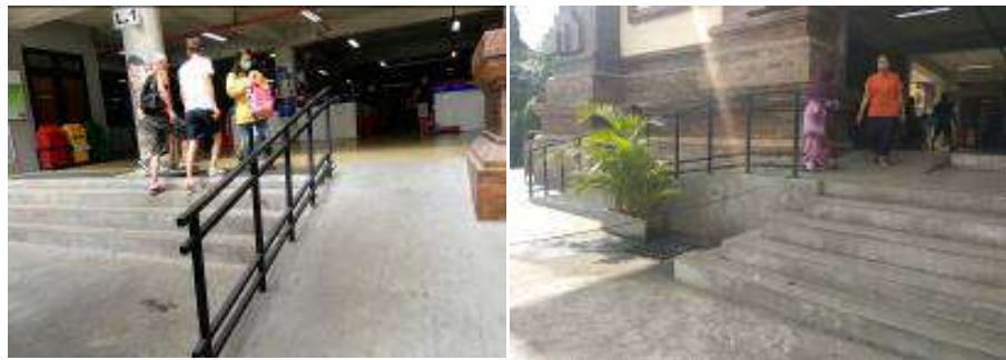
Gambar 5. Penampakan Ram dan Tangga menuju lantai 1 Sumber: Hasil Observasi, 2019
