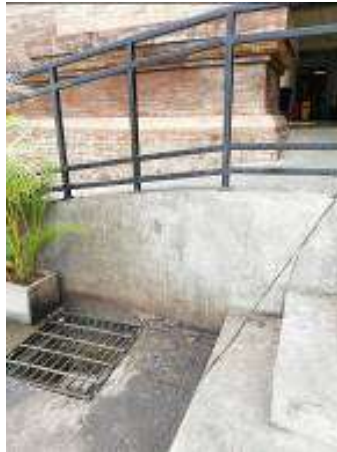
Gambar 8. Penampakan sala satu ramp yang memiliki kemiringan melebihi standar PU
