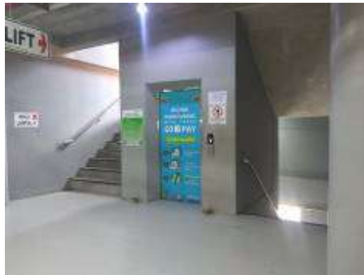
Gambar 9. Penampakaan tangga pada bangunan Pasar Badung
