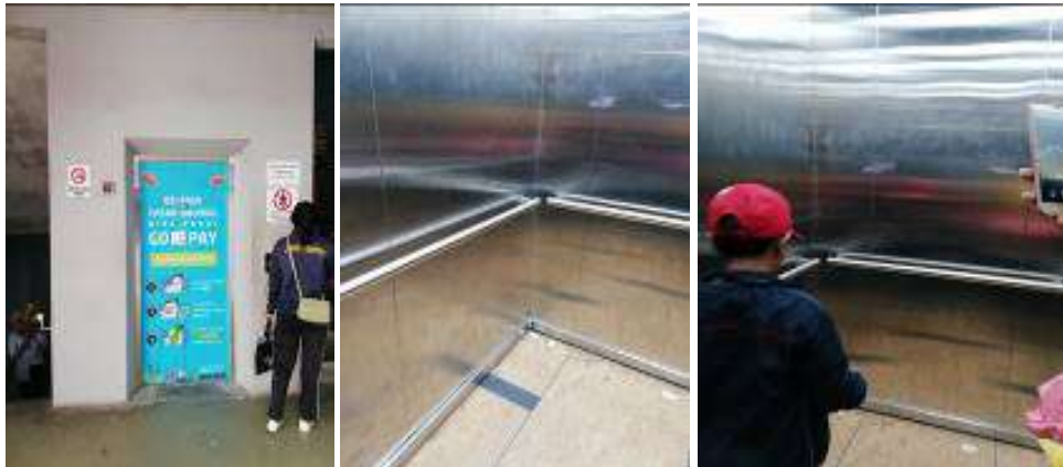
Gambar 10. Lift pada pasar Badung dilengkapi dengan reling dengan ketinggian 87 cm
