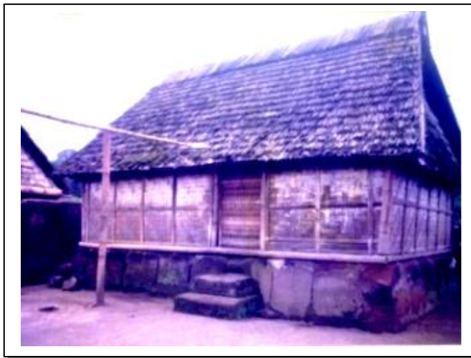
Tampak Depan Paon
