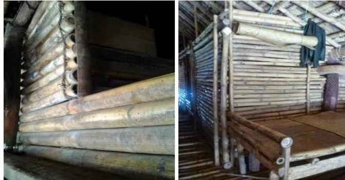
Gambar 6. Dinding Rumah Sumber: google
