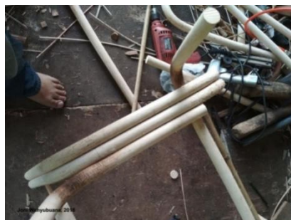
Gambar 21. Pemasangan sandaran tangan. Sumber foto: Dokumentasi Penelitian.
