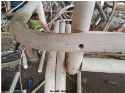
Gambar 24. Sambungan dan penguatan rangka rotan menggunakan sekrup. Sumber foto: Dokumentasi Penelitian.
