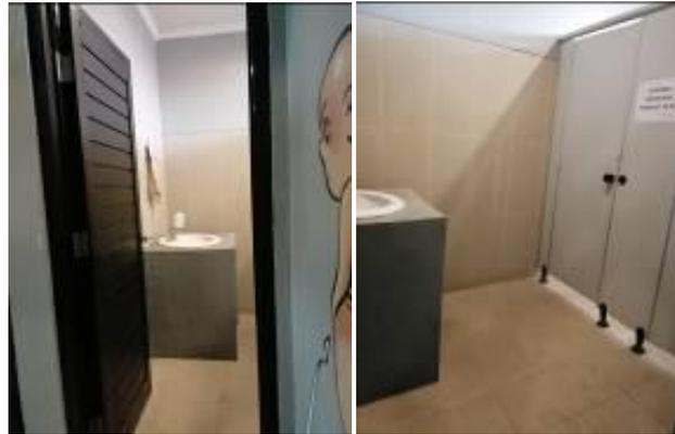
Gambar 6. Ukuran pintu toilet Pasar Badung dibawah standar PU
