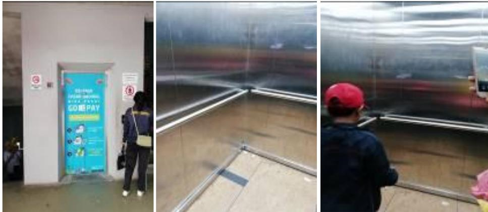
Gambar 10. Lift pada pasar Badung dilengkapi dengan relling dengan ketinggian 87 cm
